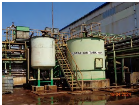
ภาพที่ 2-24 ระบบบำบัดน้ำเสียแบบเคมี และระบบแยกน้ำมันในส่วนของระบบบำบัดน้ำเสียแบบเคมี
