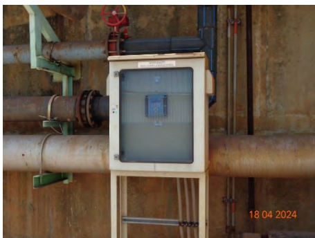
ภาพที่ 2-74 ระบบ DO Monitoring Online ป้อนตรวจสอบน้ำเข้าจากหอหล่อเย็น
