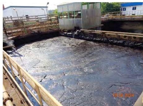
ภาพที่ 2-24 ระบบบำบัดน้ำเสียแบบเคมี และระบบแยกน้ำมันในส่วนของระบบบำบัดน้ำเสียแบบเคมี
