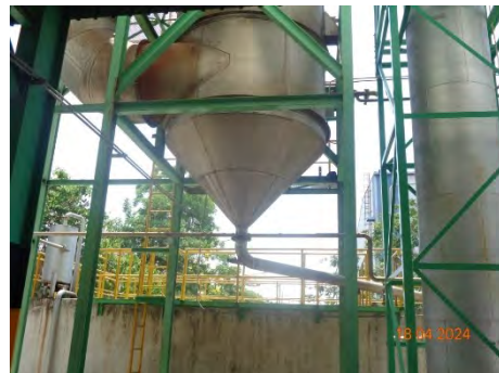
- ระบบดักฝุ่นแบบสควิบเบอร์ (Venturi Scrubber)
