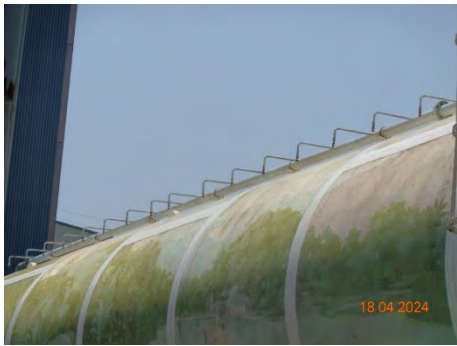
ภาพที่ 2-77 อุปกรณ์ระงับอัคคีภัย และระบบสปริงเกอร์น้ำ บริเวณพื้นที่ถังเก็บแอลพีจี (ต่อ)
