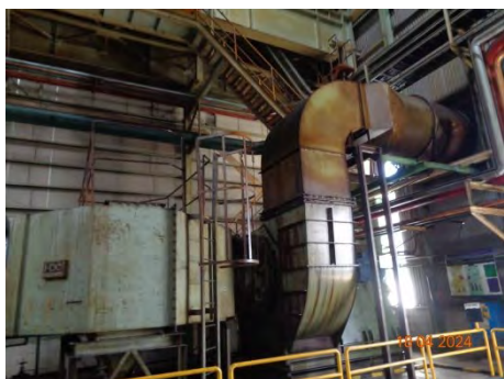
ภาพที่ 2-3 ระบบดักจับไอน้ำมันของปล่อง TM
