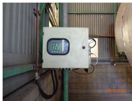
ภาพที่ 2-58 อุปกรณ์การตรวจวัดต่างๆ ของหม้อไอน้ำ
